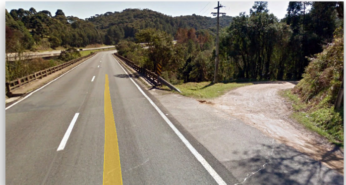
Estrada que dá acesso a Fazenda Pico Paraná
